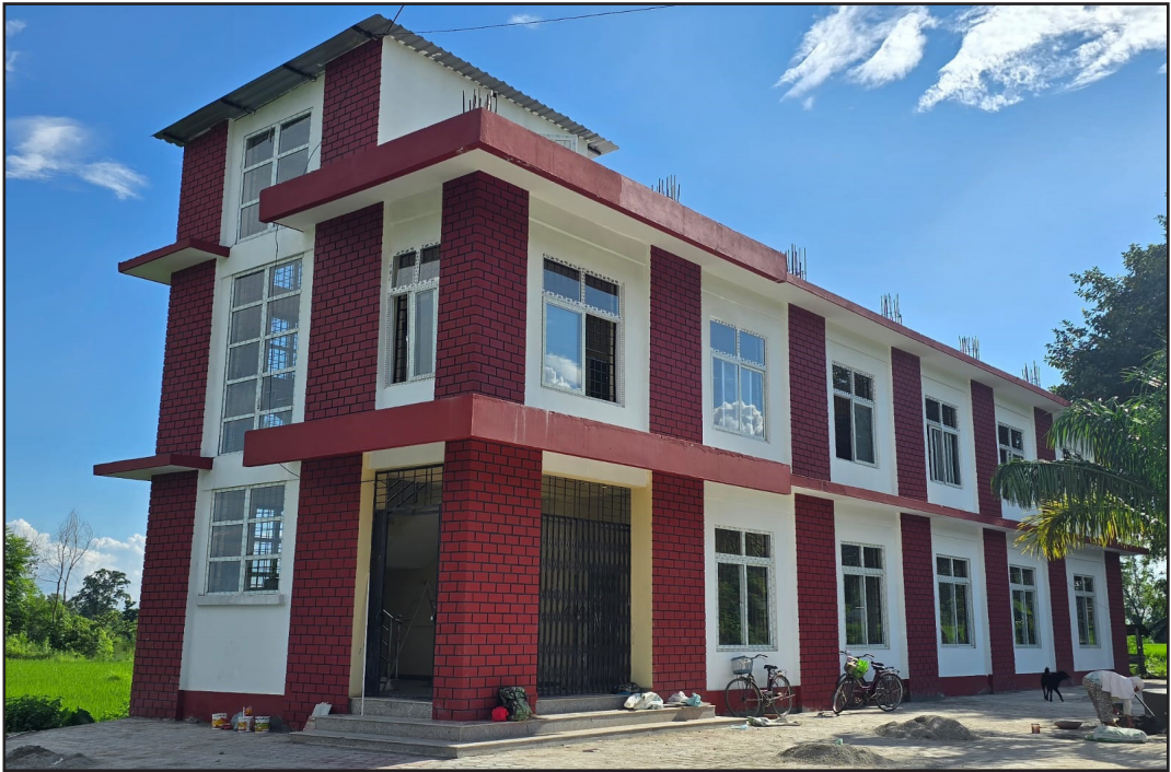
वडा नं. १५ को नवनिर्मित भवन
