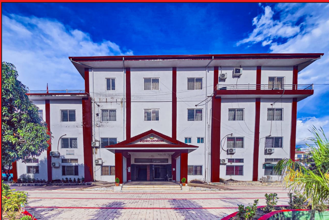
चौडाकोट नगरपालिकाको प्रशासकीय भवन
